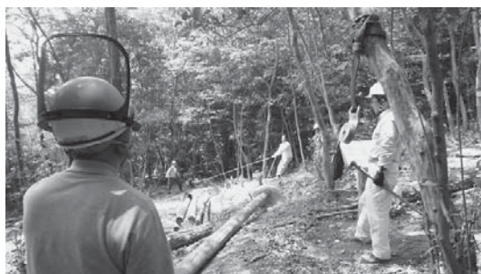
山桜フィールド整備、ウッドデッキ用材の集材
