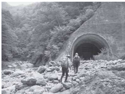
西ヶ洞で見た山中のトンネル
