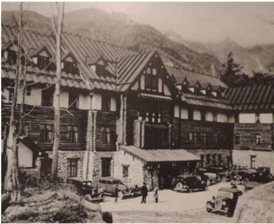
昭和8年10月5日 竣工・大倉土木
