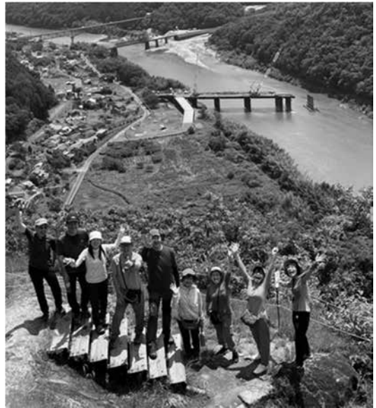
木曾川に架かる建設途上のリニア用鉄橋
