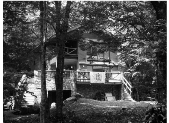
善六沢扇状地に建てられた JAC 研究所建屋
